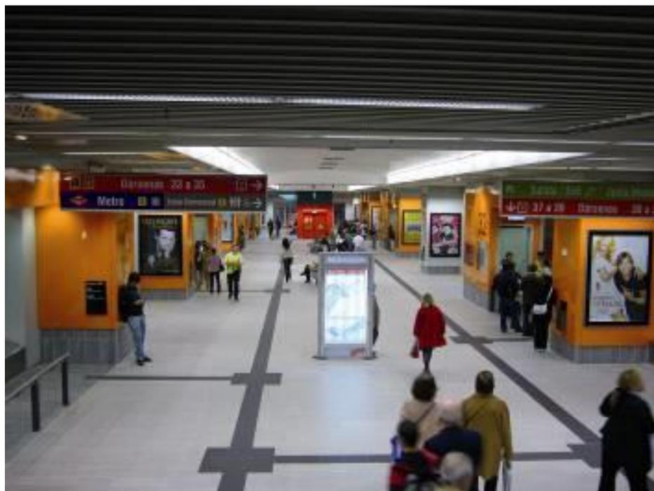
Fotografía. Intercambiador de Moncloa. Franjas-guía de encaminamiento. (Autor: J.A. Juncá)
